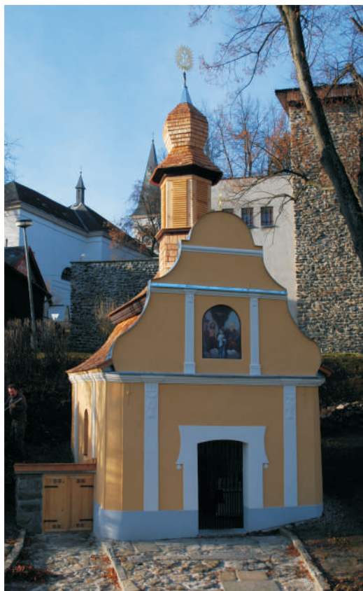
Kaplička Bolesná Panny Marie ve Stachách byla nedávno opravena.
