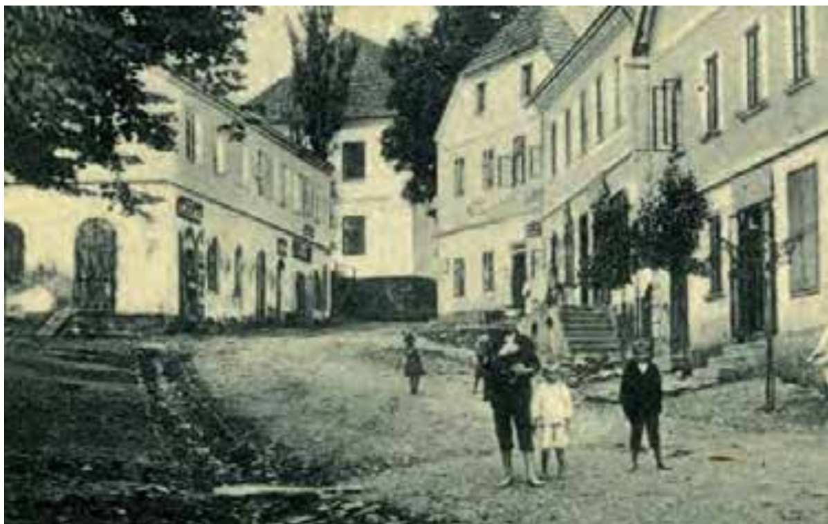
Dům „U Šafránků“ (vlevo), vpravo v pozadí hotel „U Lva“. Kanalizace na povrchu.
