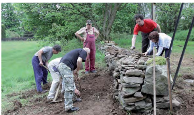
Stavba kamenné zdi
