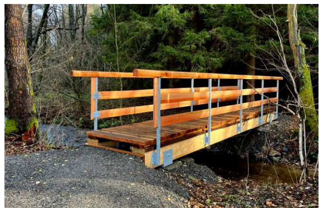
Lávka přes stašský potok
